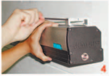
以六角扳手將兩邊掛鈎上的活動鉤之螺絲鎖緊。
